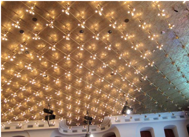
Abb. 3: Schöne Anwendung für die neue LCC-Lampe. Die Leistungsaufnahme reduziert sich auf weniger als 10 % gegenüber konventionellen Glühlampen.
